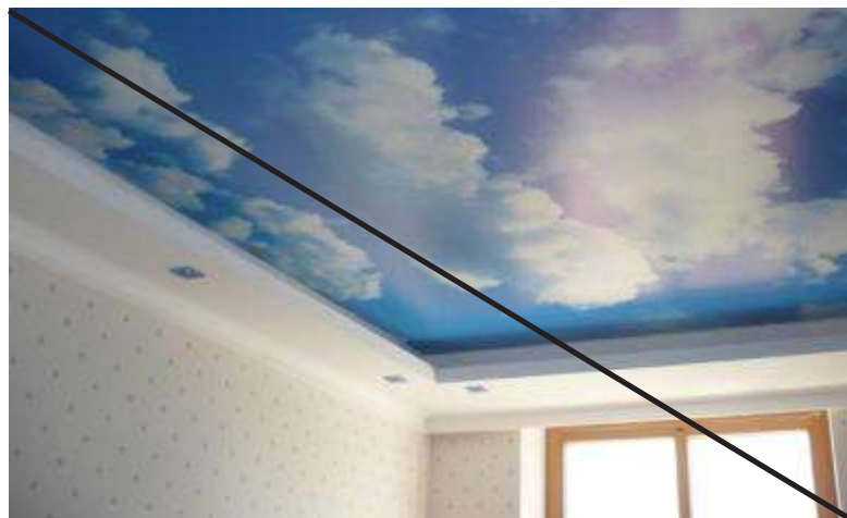
Плохо Натяжные потолки. Потолки с рисунками
